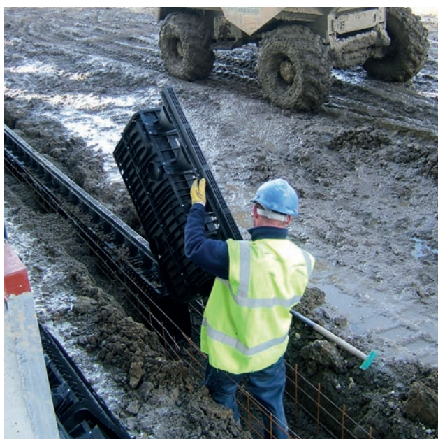
Elementi con peso ridotto, movimentati da un solo operaio
